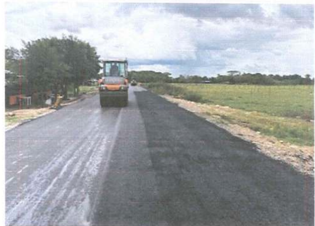
INSTALACIÓN MEZCLA DENSA EN CALIENTE MDC 19
