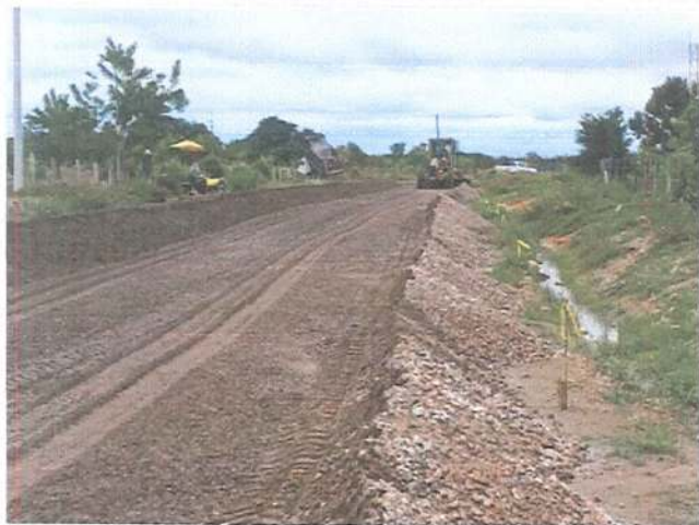
CONFORMACION DE CAPA DE BASE GRANULAR
